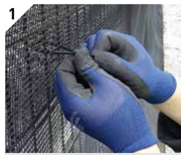
フェンス等にバリオスネットを設置します 繁茂した葛を刈り取り、フェンスにバリオスネットを取り付けます。 結束バンドでフェンスとネットを固定します。
