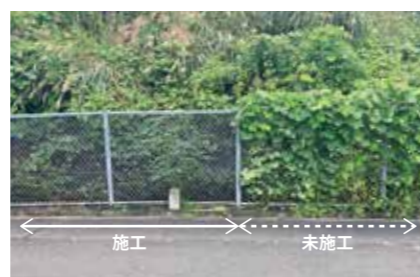
施工・未施工の比較
