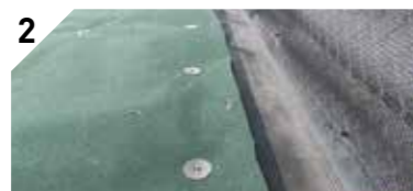
フェンス足元の処理
